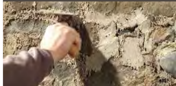
Korrektur mit gedrückter Rundspachtel
