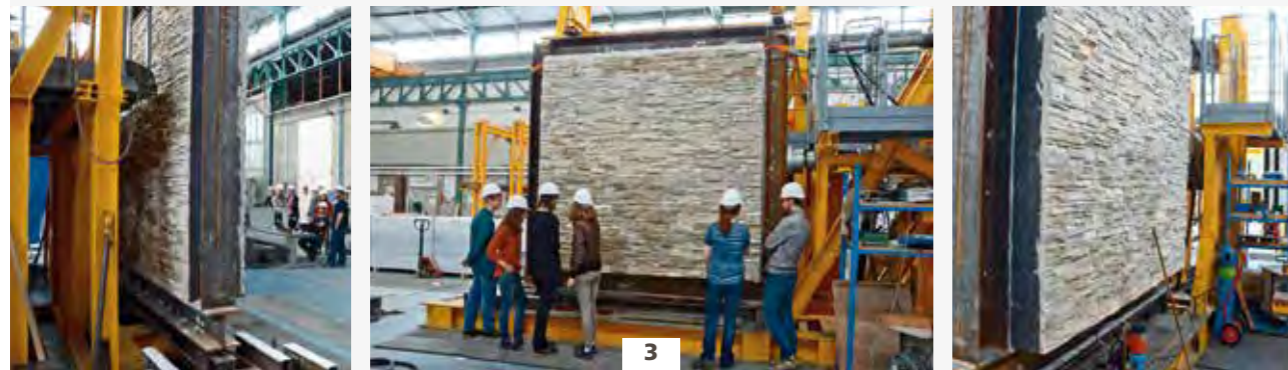
muregeopietra auf Betonbausteinen
