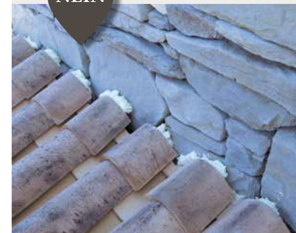
Im Bild ein Beispiel für falsche Installation.
