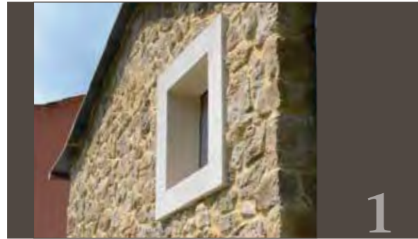
Fensterumrandung mit gespachteltem und eingefärbtem Rahmen
