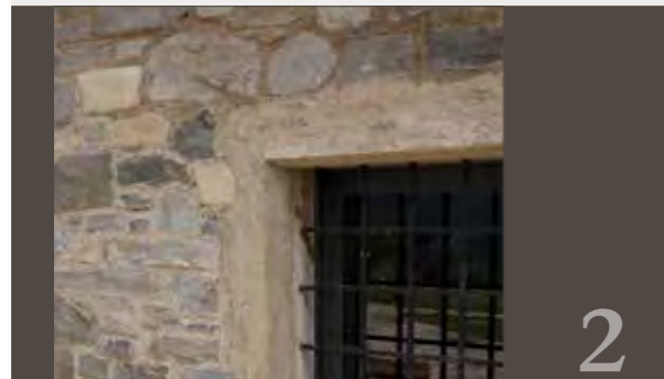
Fensterumrandung mit flächenbündig versenkten Steinen
