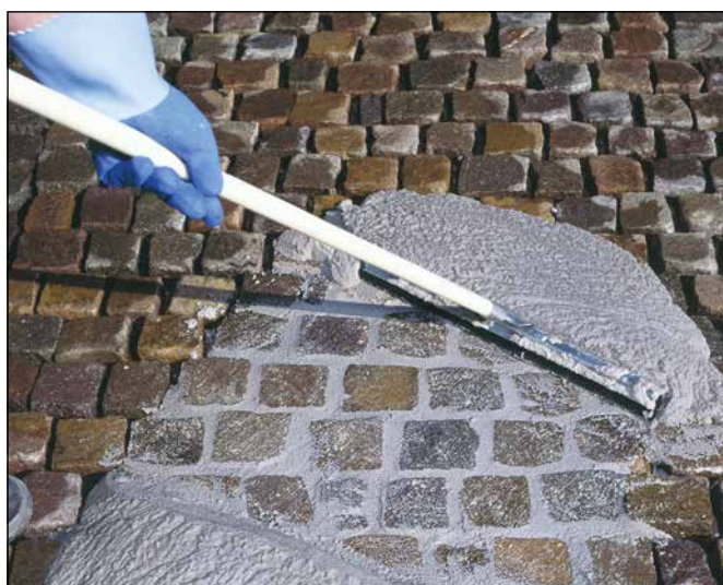
5 Fugenfüllendes Einbringen von Sopro EpoxiPflaster-Fuge 2-K.
