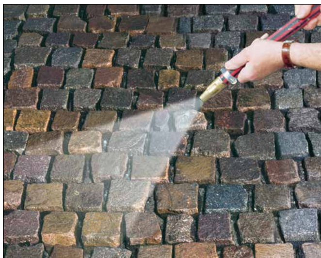
1 Vornässen des gereinigten, zu verfugenden Belags.
