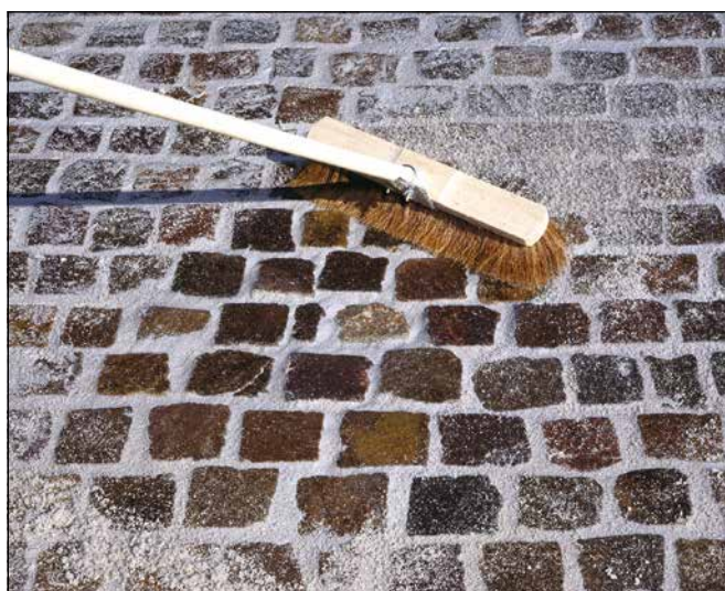
6 Säubern des verfugten Belags.
