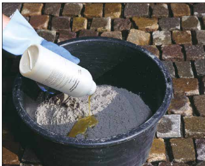
2 Härterzugabe und Anrühren von Sopro EpoxiPflasterFuge 2-K.
