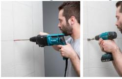
Die Bohrung erfolgt mit einem 8 mm Bohrer bis in eine Tiefe von mindestens 10 mm über die Verankerungstiefe hinaus; die Bohrungen sind sorgfältig zu reinigen. Mit einer entsprechenden Fräse wird dann eine kreisförmige Vertiefung mit 16-18 mm Durchmesser ausgeführt, um anschließend die flächenbündige Verschraubung der Dübelplatte zu ermöglichen.
