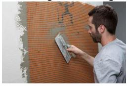
Breitmaschige Stützgewebe aus Glasfaser GEORETE mit einer
