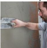
Mit einer gleichmäßigen Fertigspachtelung das Gewebe und die Dübelköpfe vollständig bedecken. Insbesondere im Fall von trocken verlegten Verblendungen, bei denen die
