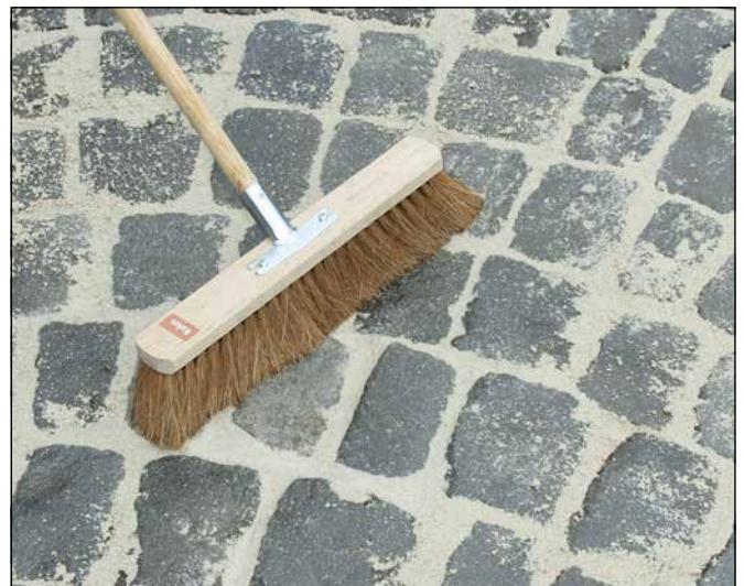
6 Säubern des verfugten Belags.
