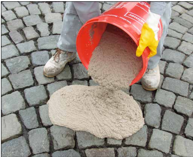
3 Verarbeitungsfähige Sopro HF® EpoxiPflasterFuge.
