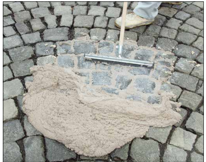
4 Gut verdichtendes Einbringen von Sopro HF® EpoxiPflasterFuge.
