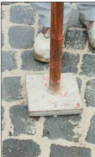
5 Intensives Verdichten von Sopro HF® EpoxiPflasterFuge mit Stampfer bzw. Fugeisen.
