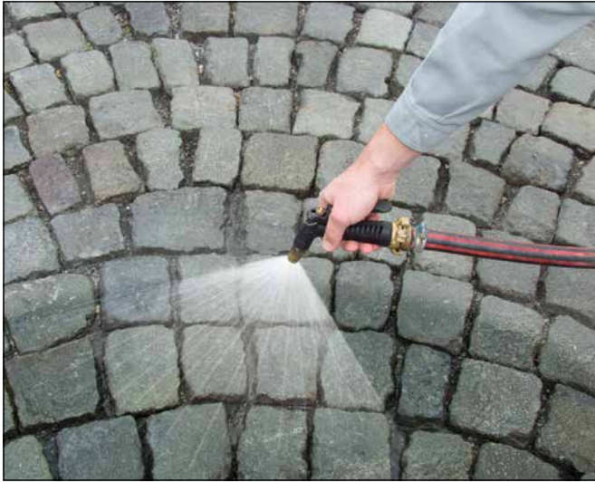
1 Vornässen des gereinigten, zu verfugenden Belags.
