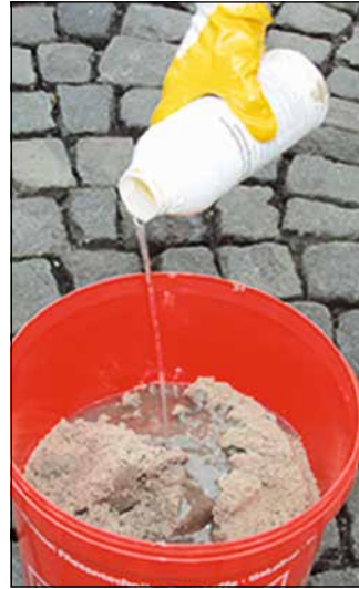
2 Härterzugabe und Anrühren von Sopro HF® EpoxiPflasterFuge. Nach dem Anrühren maximal 2l Wasser zugeben und erneut anrühren.
