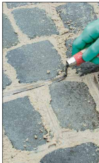
5 Intensives Verdichten von Sopro HF® EpoxiPflasterFuge mit Stampfer bzw. Fugeisen.
