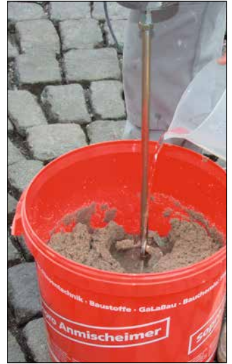
2 Härterzugabe und Anrühren von Sopro HF® EpoxiPflasterFuge. Nach dem Anrühren maximal 2l Wasser zugeben und erneut anrühren.
